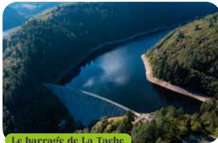
Le barrage de La Tâche
